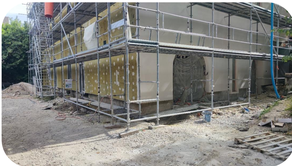
Isolation thermique par l'extérieur en laine de roche
