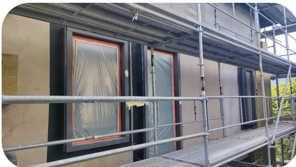
Pose des nouvelles menuiseries au nu extérieur
